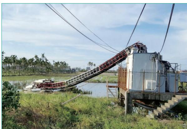
圖9 屏東縣東港鄉下節鐵塔倒塌情形
