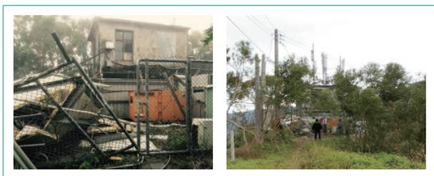
圖5 屏東縣霧臺鄉吉露鐵塔倒塌，中華電信先於原站點旁之2層樓建物架設天線復臺服務
