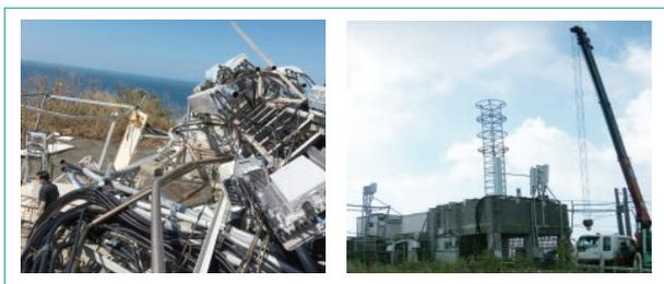
圖6 屏東縣恆春鎮水泉鐵塔倒塌，中華電信先以臨時基地臺復臺服務
