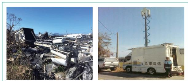
圖3 臺東縣豐源鐵塔倒塌，中華電信先在附近架設移動式基地臺恢復通訊
