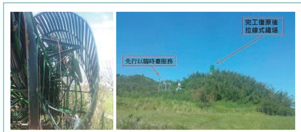
圖4 臺東縣富岡鐵塔折彎，中華電信先以臨時基地臺復臺服務
