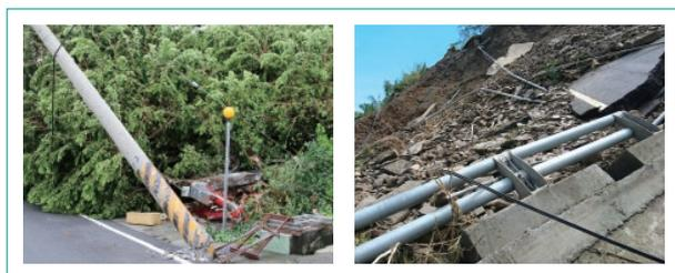
圖7 大量路樹傾倒或道路中斷，壓損通信設施
