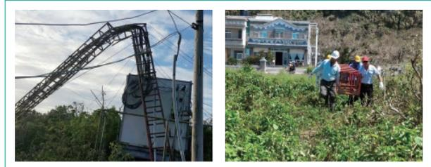
圖2 臺東縣綠島鄉公館鐵塔倒塌，中華電信先行搬運1節鐵塔附掛在機櫃處架設天線復臺服務
