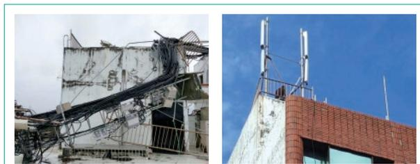
圖1 臺東縣公東8米鐵塔倒塌，中華電信先行於屋突欄杆處架設天線，後再新建8米鐵塔
