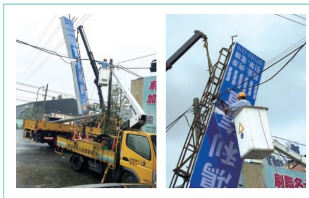
圖6 吊桿車與高空車協同作業搶修電纜
