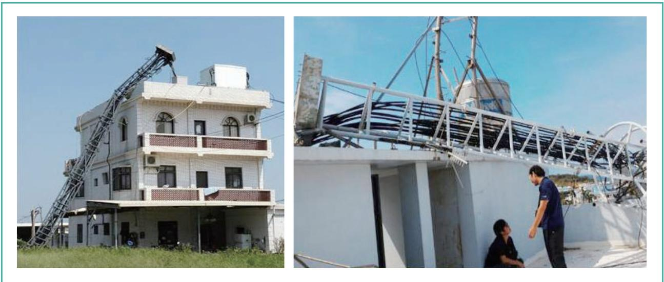
圖3 中繼微波鐵塔倒塌情形
