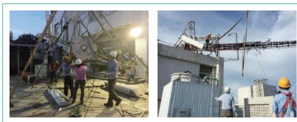
圖7 為免墜落物傷及路人，中華電信連夜將倒塌之鐵塔及相關設施拆除淨空
