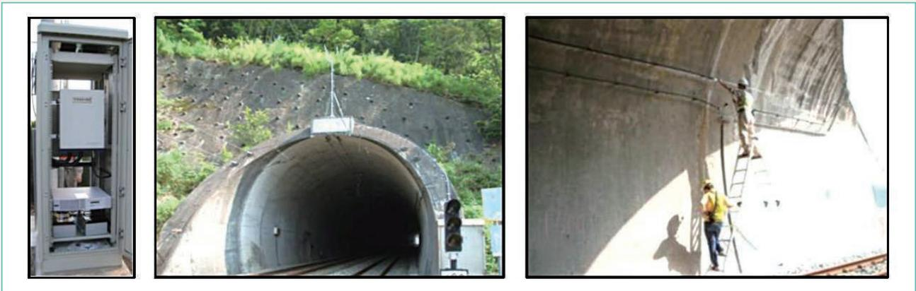
圖5 中繼站內部（左圖），隧道口天線設置（中圖），隧道漏波電纜設置（右圖）
