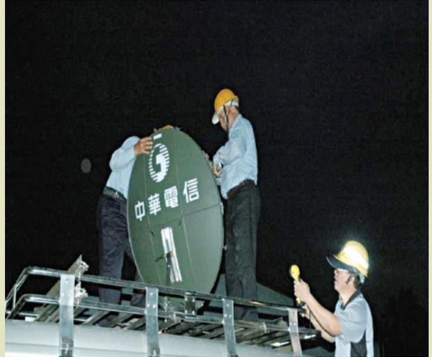
圖三、於災區利用衛星移動式基地臺恢復通信。
